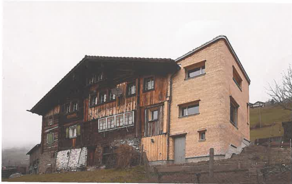
Architektur Baumann AG: Restig 1, Spiringen UR, Umbau 2019/2021. Ein Praxisbeispiel für das von Margrit Baumann propagierte Weiterbauen im Bestand: Der Holzblockbau, auf Ende 15. Jh. datiert, wird unter Wahrung der Setzung und der Baustruktur um eine Zimmerachse über drei Geschosse erweitert. (Fotos und Pläne: zVg)
