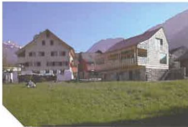
Architektur Baumann – oben: «Hofstatt zur Stiege», Bürglen, Stand vor dem Umbau (Foto Gian Salis); unten: nach dem Umbau (Neubau Scheune: Loeliger Strub Architektur), 2000–2003 (Foto Loeliger Strub Architektur).
