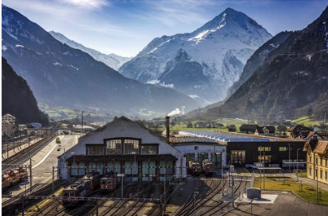
Verkehrsinfrastruktur und Siedlungsentwicklung stehen in enger räumlicher und funktionaler Wechselwirkung zueinander (im Bild rechts: Neubau des AlpTransit-Erhaltungs- und Interventionszentrums Erstfeld).
