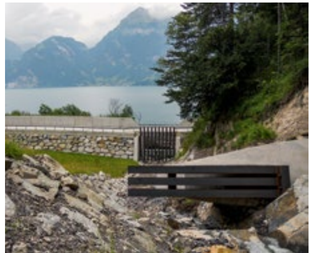
Murgangsbremse und Geschiebesammler am Dornbach bei Sisikon UR.
