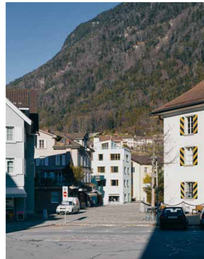
Ersatzneubau am Haus am Lehnplatz
